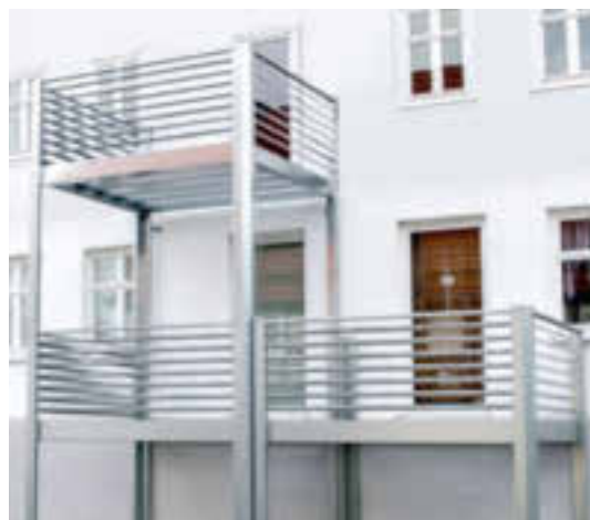
Verzinkte Balkonanlage mit mehreren Balkonen über- und nebeneinander (mit Lamellengeländer)
