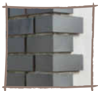
Fassadenrenovierung mit „Gotland“-Winkelriemchen
