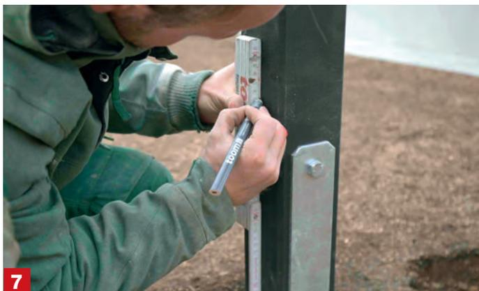
**7** **Winkel in die Zaunpfosten schrauben** Dank des Schnellbetons kannst du die Pfosten schon nach 15 bis 20 Minuten mit den Zaunelementen verbinden. Zuerst aber die gewünschte Position der Winkel an den Zaunpfosten anzeichnen und die Löcher mit einem dünnen Bohrer vorbohren. Dann kannst du die Winkel in die Zaunpfosten schrauben.
