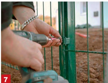
**7 Montieren** Die erste Stabmatte wird aufrecht gestellt und zuerst an den Mattenhaltern des Pfostens eingehängt. Auf der anderen Seite wird sie vorübergehend auf Pflastersteine oder Kanthölzer aufgebockt, sodass sie gerade steht. Mit einem Akkuschrauber fixierst du die Matte am Pfosten – anfangs nur leicht! Schrauben gerade einführen, damit sie sich nicht verkanten. Vorher überlegen, welche Seite außen und welche innen liegen soll.
