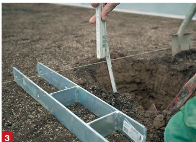
**Pfostenlöcher graben** Hebe die Löcher für die Fundamente der Pfosten mit einem Spaten (noch besser mit einem Erdbohrer) aus. Die Tiefe hängt von der Frosttiefe des Bodens in deinem Garten ab. 80 cm sind in unseren Breiten gängig, aber es könnten auch 50 cm okay sein. Steht der Zaun an einer windigen Stelle, dann lieber etwas tiefer graben, damit der Zaun nicht kippt. Am besten ist es, wenn das Loch quadratisch ist, mit einer Seitenlänge von etwa 40 cm.
