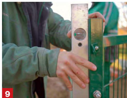
**9 Überprüfen** Kontrolliere immer wieder mit der Wasserwaage und der Richtschnur, ob Höhe und Verlauf des Zauns und der Pfosten stimmen. Ziehe dann mit dem Akkuschrauber die Schrauben fest. Jetzt kannst du die Abdeckungen oben auf die Pfosten drücken oder mit einem Gummihammer vorsichtig fixieren. Nachdem der Beton vollständig ausgehärtet ist, werden die verbleibenden obersten 10 cm des Lochs mit Erde aufgefüllt.
