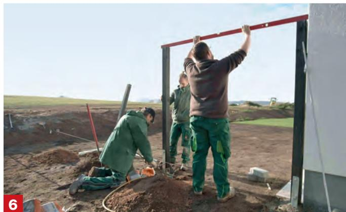
**6** **Pfosten einsetzen** Setze den Pfosten mit dem H-Anker so in den feuchten Beton ein, dass etwa 5 bis 10 cm Bodenfreiheit verbleiben. Während der Beton erhärtet, richtest du mit einer Wasserwaage den Pfosten senkrecht aus und zwar längs und quer zum Zaun. **Wichtig:** Darauf achten, dass die Pfosten alle die gleiche Höhe haben, sonst sieht der Zaun nachher schief aus. Hier hilft es, zu zweit zu sein.
