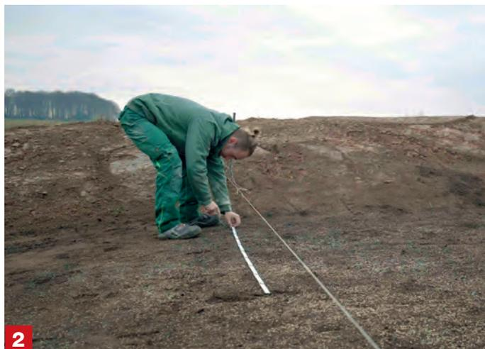
**Bestimme den Verlauf** Spanne mit einer Richtschnur den genauen Verlauf des Zaunes ab und markiere die Abstände der Pfosten im Boden – am besten mit Erdankern oder Schnurnägeln. Die Schnur markiert die Zaununterkante, sie soll einige Zentimeter über dem Boden verlaufen. Im Beispielfall sind die Zaunelemente 1,80 m breit. Das heißt, dass die Pfosten auch 1,80 m entfernt voneinander stehen müssen. Überprüfe die rechten Winkel an den Zaunecken mit einem Schlosserwinkel.
