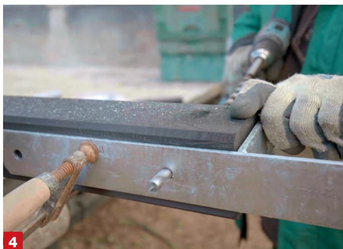
**H-Anker an die Pfosten schrauben** In einem Zwischenschritt schraubst du jetzt die H-Anker, also die Metallhalterungen, in denen die Pfosten befestigt werden, an das Pfostenholz. Es ist einfacher, wenn du dies tust, bevor die Pfosten ins Fundament gesetzt werden.
