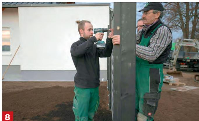
**8** **Zaunelemente an die Pfosten montieren** Jetzt ist wieder Sorgfalt gefragt: Richte die Zaunelemente nacheinander mit der Wasserwaage aus und schraube die Winkel in die Zaunelemente. **Tipp:** Am besten ist es, wenn du kurze Kanthölzer oder Keile unter das große und unhandliche Zaunelement legst. Das stützt und verhindert, dass zu große Zugkräfte auf die einzementierten Pfosten wirken können, bevor der nächste Pfosten montiert wird.
