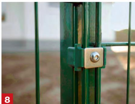
**8 Die nächsten Pfosten setzen** Nun folgen im Wechsel die nächsten Pfosten und Zaunelemente. Achtung: Bei den Eckpfosten musst du vor dem Einbetonieren unbedingt darauf achten, dass die Aufhängevorrichtungen für die Zaunelemente auf der richtigen Seite sind.
