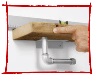
Mit der Wasserwaagen die Bohrlöcher festlegen.
