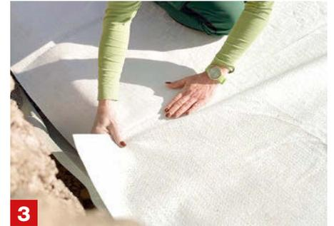
**3** **Fundament säubern** und danach das Vlies ausbreiten. Hast du mehrere Teile, kannst du sie Stoß auf Stoß legen oder etwas überlappen lassen. Alles solltest du mit Sprühkleber oder doppelseitigem Klebeband befestigen. Hinterher das Vlies säubern.
