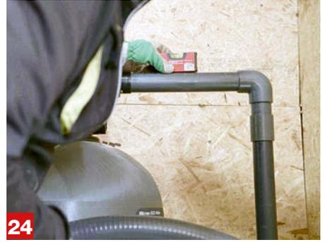
**24 Nivellieren und stabilisieren** Um Pumpe und Filter zu verbinden, wiederholst du den im vorherigen Schritt beschriebenen Vorgang: Rohr auf die geeignete Länge zuschneiden, mit PVC-Kleber bestreichen und die Teile ineinanderstecken. Nun montierst du ein Schraubgewinde und befestigst es an dem Anschluss der Pumpe. Bringe die restlichen Rohre an und überprüfe mit einer Wasserwaage, ob sie eben angebracht wurden.
