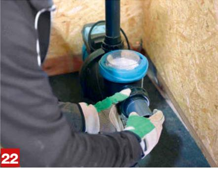
**22 Pumpe anschließen** Dafür beginnst du mit der Saugseite der Pumpe, wo das Wasser ankommt, das gefiltert werden soll. Zunächst verbindest du den Zulauf des Skimmers mit der Pumpe und dann bringst du den Kugelhahn an. **Tipp:** nicht mit Kleber sparen. Bestreiche auch das Rohr des Kugelhahns gut damit.
