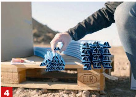
**4** **Bodenschienen auslegen** Sie werden im Kreis zusammengesteckt und auf das Vlies gelegt. Die Poolstahlwand gibt hierfür die Länge vor. **Tipp:** Miss den Durchmesser der ausgelegten Schienen und vergleiche ihn mit den Poolmaßen. Sind sie zu unterschiedlich, kannst du, je nach Bedarf, eine Schiene hinzufügen oder entfernen.
