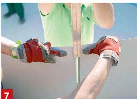
**7** **Enden verbinden** Zwischen den beiden Enden der Poolwand solltest du etwa 0,5 cm Platz aussparen. Du verbindest sie dann mit einer sogenannten Verbindungsschiene, die mit einem Gummihammer bis zur Bodenschiene geklopft wird. Jetzt kannst du die Stahlwand noch bewegen und auf dem Fundament richtig positionieren.
