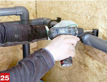
**25 Mit Schellen an der Wand befestigen** Der Vorgang der Installation der Rohre wiederholt sich auch bei der Verbindung der Filteranlage mit dem Düsen Schlauch. Hast du auch diese Rohre zugeschnitten, gesäubert, verklebt und verschraubt, befestigst du die Rohre am besten mit Schellen an der Wand. **Tipp:** Montiere außerdem noch einen weiteren Kugelhahn, um falls nötig den Wasserlauf zu unterbrechen.
