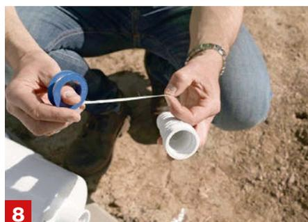
**8** **Skimmer (Oberflächenabsauger) installieren** Die Schlauchanschlussstülle des Skimmers muss zur Abdichtung vorab ordentlich mit Teflonband umwickelt werden. Danach drehst du sie an den Skimmer. Jetzt kannst du die Skimmer-Dichtung an die Aussparung im Pool klemmen und dann den Skimmer anschrauben.
