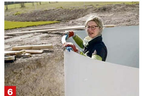
**6** **Für mehr Stabilität** kannst du einige Handläufe auf die obere Kante stecken, dadurch wird die Wand stabiler und das Einstecken in die Bodenschienen geht leichter. Falls du einen Blechüberschuss hast, kannst du ihn ausmessen und die Bodenschiene passend zuschneiden, anstecken und das restliche Blech einsetzen.
