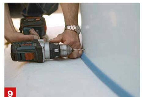
**9** **Platzierung des Erdungskabels** Hierfür kannst du die Stahlwand im unteren Bereich anbohren und das Erdungskabel mit einer Metallschraube und etwas Vlies als Polsterung befestigen. Von dort aus wird das Kabel dann zu einem Erdungspfahl verlegt. Dies lässt du besser einem Experten machen – siehe auch „Übrigens...“, Seite 13.
