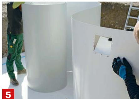
**5** **Stahlwand aufstellen** Die Innenseite der Poolwand ist grau, die Außenseite weiß. Rolle die Stahlwand vorsichtig und langsam ab. Jetzt kannst du auch schon das Skimmerblech aus der Aussparung herausbrechen.
