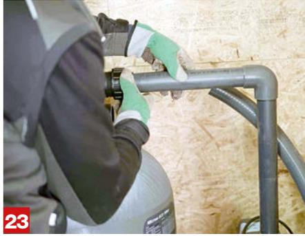
**23 Rohre befestigen** Markiere zunächst das Zulaufrohr und kürze es anschließend auf die richtige Länge. Jetzt spitzt du die Oberfläche zu und reinigst sie. An der Innen- und Außenfläche des Rohrs wieder reichlich Kleber auftragen, alles zusammenstecken und antrocknen lassen.
