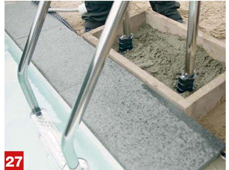
**27 Die letzten Schritte** Du hast es fast geschafft: Das Wasser ist eingelassen, die Erde den Pool ist aufgeschüttet und es fehlt nur noch die Poolleiter. Verschraube die Sprossen der Leiter mit den Führungsrohren und bringe die Füße an. Damit die Leiter fest sitzt, baue noch einen Betonsockel, in den du das Ende der Führungsrohre setzt und erdest. Jetzt bist du fertig und kannst dich auf dein erstes Bad im selbst aufgebauten Pool freuen.
