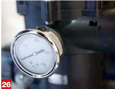
**26 Druckanzeige montieren** Zu guter Letzt bringst du noch die Druckanzeige am Filter an. Wickle etwas Teflonband um das Ventilgewinde. Wichtig: nur handfest anziehen, weil das PVC-Gewinde schnell beschädigt werden kann. Jetzt musst du nur noch für die Rückspüloption ein Rohr an der Ablaufseite anschrauben. Empfehlenswert ist, alle ein bis zwei Wochen eine Rückspülung durchzuführen.
