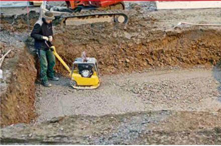
**Rüttelmaschine** Damit die Tragschicht aus Schotter auch gut verdichtet wird, machst du das am besten mit einer Rüttelmaschine. Achte darauf, dass die Ränder gut verdichtet sind, denn hier sitzt später die Schalung. Eine Rüttelmaschine kannst du tage- oder stundenweise bei deiner toom Filiale vor Ort mieten. Mehr erfährst du unter [www.toom.de/service/mietgeraeteservice](http://www.toom.de/service/mietgeraeteservice)
