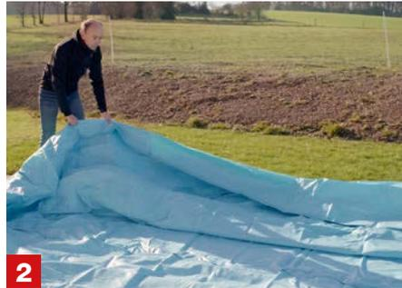
**2** **Poolfolie ausbreiten** Damit sich die Falten der Poolfolie aus wärmeplastischem Material glätten, lege sie in die Sonne, um sie aufzuwärmen.
