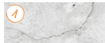
Wand mit Rissen
