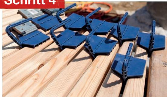
Alle weiteren Dielen setzt du mit einem Abstand von etwa fünf Millimetern und verschraubst sie ebenfalls mit der Unterkonstruktion.
