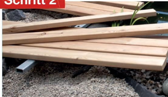
Du fertigst eine Unterkonstruktion, z. B., indem du Längs- und Querbalken mithilfe von Montagewinkeln verbindest.
