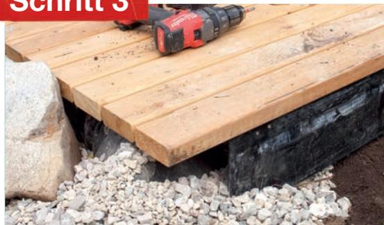
Du startest mit der Beplankung: Mit einem Hilfsbrett als Anschlag verlegst du die erste Diele. Verschraube die Dielen immer mit zwei Schrauben je Konstruktionsholz. Edelstahlschrauben mit Selbstbohrspitze ersparen zeitraubendes Vorbohren.
