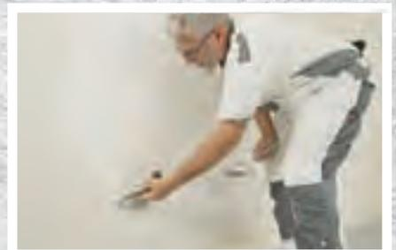
*Nun muss der Untergrund gründlich gereinigt werden. Unebenheiten, Risse und Löcher bearbeitest du mit dem Bandschleifer bzw. mit Spachtelmasse, um eine ebene Fläche zu erhalten. Sandiger oder stark saugfähiger Untergrund muss vor dem Tapezieren mit Tiefgrund grundiert werden. Nach dem Abtrocknen ist der Untergrund dann perfekt vorbereitet, damit sich die Tapete später nicht ablöst.*
