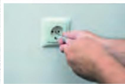
*Bevor du loslegst: Den Strom über die Sicherung abstellen! Abdeckungen von Steckdosen und Lichtschaltern entfernen, Stromkabel mit einer Lüsterklemme sichern. Zum flächigen Arbeiten die Fußleisten entfernen. Möbel und Böden mit Folie oder einem Abdeckvlies abdecken.*
