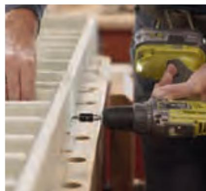
Die Schrauben mit einer Unterlegscheibe an den Rahmenstücken zur späteren Lamellenbefestigung ansenken, danach je eine kurze und eine lange Rahmenseite miteinander verleimen. Die Lamellen mit je zwei Unterlegscheiben einseitig am Rahmen verschrauben. Die zweite lange Rahmenseite montieren und mit den Lamellen verschrauben. Zum Schluss Schamiere und Filzgleiter anbringen.
