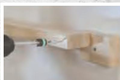
Schraube in der oberen Reihe zwei Leisten als Auflage für die Ablage an. In der unteren Reihe genügt eine Leiste. Achte darauf, dass beide Leisten den gleichen Abstand zur Wand haben.
