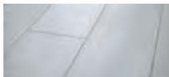
Bei Laminat mit 4-V-Fuge verfügen alle Seiten eines Laminatpanels über eine umlaufende Kantenfuge, die zwischen einzelnen Planken eine kleine Fuge entstehen lässt. Dadurch ist jedes einzelne Brett auch nach der Verlegung noch erkennbar und es wird die Optik eines authentischen Holzdielenbodens erzeugt.
