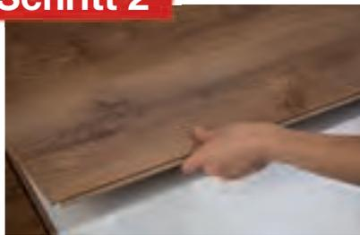
Durch einen kurzen Druck mit dem Daumen die Diele einrasten lassen. Wenn du das „Klick“ hörst, ist die Verbindung fixiert.
