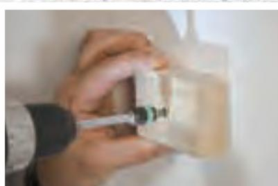
Bohre auf Höhe der Ablage in gleichmäßigem Abstand 3 Löcher und befestige 3 Holzklötze flach an der Wand. Das gleiche unten wiederholen und zusätzlich einen Klotz hochkant auf dem ersten anschrauben.
