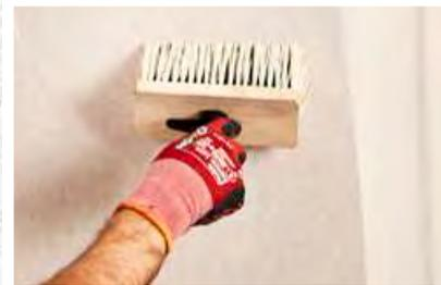
Wand mit einer Malerquaste und Wasser nässen, bis sie gut feucht ist – so kann sie den Putz am besten aufnehmen.
