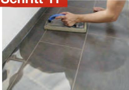
Bevor du mit einem weichen Schwamm oder Schwammbrett den Mörtelschleier wegwischen kannst, lässt du ihn am besten leicht antrocknen. Das Waschwasser solltest du häufiger wechseln und das Schwammbrett stets gut ausdrücken. Wichtig: niemals einen scharfen Reiniger oder Schwämme mit kratziger Oberfläche verwenden!
