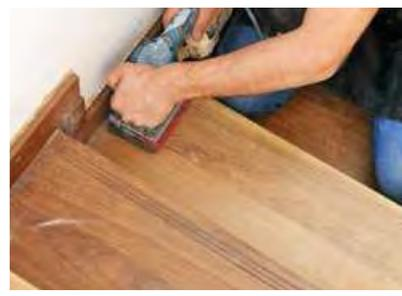
Atemschutzmaske anlegen und die Flächen der Stufen mit dem Schwingschleifer abschleifen. Für die Ecken einen Deltaschleifer oder eine Ziehklinge verwenden. Schmutz absaugen.
