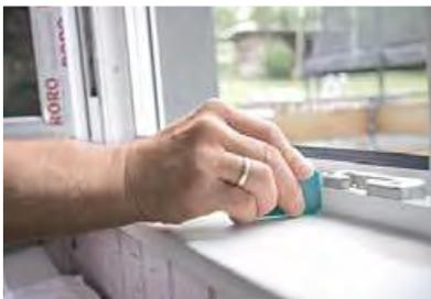
Ist der Montagekleber vollständig getrocknet, kannst du die Fuge zwischen Blendrahmen und Fensterbank mit Silikon versiegeln und mit einem Silikonabzieher in Form bringen.
