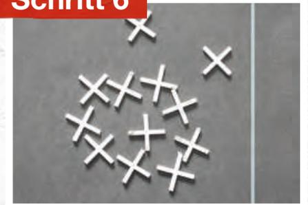
Gleichmäßige Abstände zwischen den einzelnen Fliesen kannst du auch mit sogenannten Fliesenkreuzen erzielen. Du bekommst sie bei toom für Fugen von 2 bis 8 mm. Diese legst du einfach zwischen zwei Fliesen und drückst dann die Fliesen mit einer leichten Drehbewegung in das Kleberbett und an das Fliesenkreuz heran. Wenn nötig, die Fliese noch mit einem Gummihammer leicht festklopfen.
