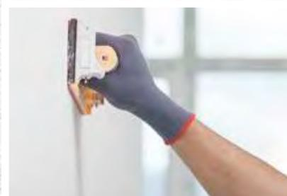
Putz mit einer Kartätsche glatt ziehen oder mit einem Reibebrett die gewünschte Struktur erzeugen, dann durchtrocknen lassen.
