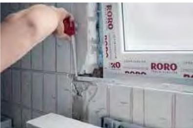
Für den Einbau einer Fensterbank solltest du zuerst die genaue Nischenbreite ausmessen und an der Fensterbank anzeichnen. Jetzt kannst du sie mit einer Handkreissäge und Führungsschiene zuschneiden.
