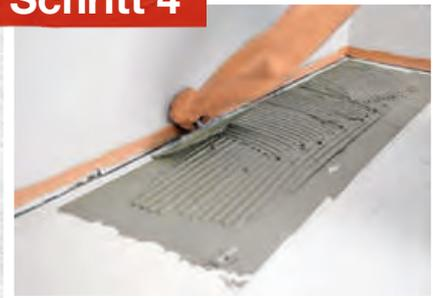
Den Fliesenkleber trägst du mit einer Kelle oder Traufel auf den Untergrund auf. Mit einem Zahnpachtel kämmst du den Kleber so durch, dass ein gleichmäßiger Auftrag entsteht. Die Zahnung des Spachtels wählst du entsprechend der Fliesengröße bzw. -rückseite und dem Untergrund. Je größer die Fliese oder je rauer die Fliesenrückseite, desto gröber die Zahnung. Beispiel: Fliesengröße 20 x 20 cm, Zahnung 8 mm.
