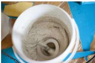
Putzmörtel mit Wasser vermengen, bis keine Klumpen mehr zu sehen sind; einige Minuten ruhen lassen; noch einmal durchrühren.
