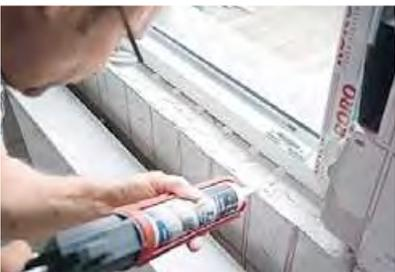
Verleime die Fensterbank nun punktwise mit Montagekleber in der Mauernische und stecke sie ein. Kontrolliere, ob sie waagrecht und im 90-Grad-Winkel zum Fenster sitzt.
