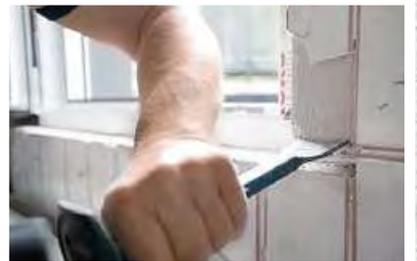
Störendes Mauerwerk stemmst du weg und saugst alles gut ab. Die Fläche muss staubfrei sein. Prüfe, ob die Fensterbank passt und waagrecht sitzt. Achte auch darauf, dass der Überstand gleichmäßig ist.
