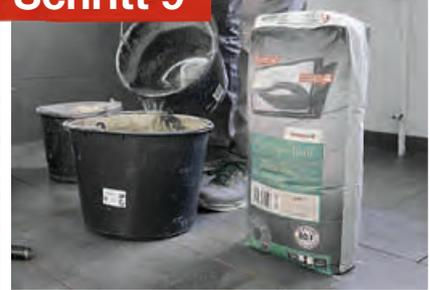
Säubere die Fugen direkt beim Verlegen mit einem Holzkeil und mische den Mörtel gemäß Herstelleranleitung (!), bis er eine sämige Konsistenz aufweist. Dann schüttest du die Fugenmasse auf die Fliesen und arbeitest sie mit einem Fugengummi gleichmäßig diagonal in die Fliesenzwischenräume ein, ohne dass Löcher entstehen oder überschüssige Masse auf den Fliesen zurückbleibt. Gut trocknen lassen!
