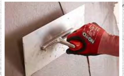
Putz anwerfen und mit einer Glättkelle verstreichen, bis die Putzschicht etwa 1 cm stark ist. Einige Stunden trocknen lassen.
