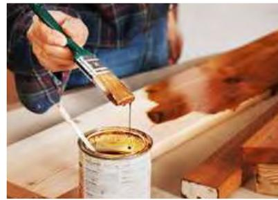
Oberflächen mit einem fusselfreien Tuch reinigen, die Treppenstufen mit Öl oder Lack grundieren, 20 bis 45 Min. trocknen lassen.
