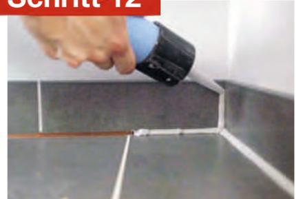
Verwende bei Eck-, Dehn- und Anschlussfugen eine dauerelastische Dichtmasse wie Silikon – Mörtel würde Risse bilden. Mit einer Kartuschenpistole drückst du die Masse gezielt in die Fugenspalte. Zum Glattstreichen benetzt du die Fuge mit etwas Wasser oder Glättmittel und ziehst deinen Daumen mit gleichmäßigem Druck über die Silikonspur.
