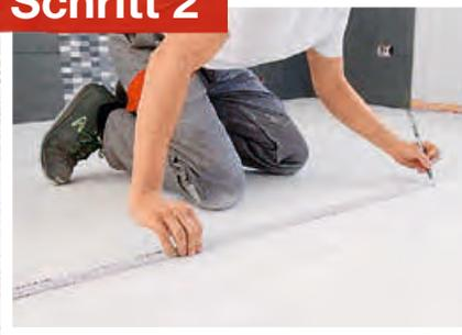
Zuerst solltest du die Fliesen im gewünschten Muster auf dem Boden auslegen. Hast du dein Muster gefunden, nimm dir einige Fliesen und miss die Länge inklusive Fugen aus. Mit diesem Maß kannst du dir jetzt Winkelstriche auf dem Boden einzeichnen. Zeichne die Länge und Breite der Fliesen grob auf den Boden, um bei der Verlegung ein symmetrisches Bild aus ganzen Fliesen und eventuellen Schnittstücken zu erhalten.
