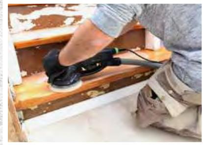
Mit Spachtelmasse und Holzkitt kleinere Macken ausbessern, mit Holzkeilen und Holzschrauben die Stufen stabilisieren.
