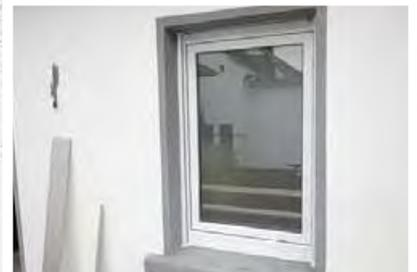
Als Letztes entfernst du die Folien am Fensterflügel. Am Rahmen solltest du die Folie so lange belassen, bis du mit deinen Wandarbeiten fertig bist. Das war der letzte Schritt und dein neues Fenster ist fertig eingebaut.
