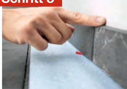
Lass beim Anbringen einer Sockelleiste mindestens eine Fugenbreite Abstand zwischen der Unterkante der Sockelleiste und der Bodenfliese. Auch bei Übergängen zu anderen Räumen solltest du darauf achten, dass die Breite der Dehnungsfuge beibehalten wird. Sitzt ein Sockel zu tief, gleiche den Höhenunterschied mit einem Keilchen aus, bis der Kleber getrocknet ist.
