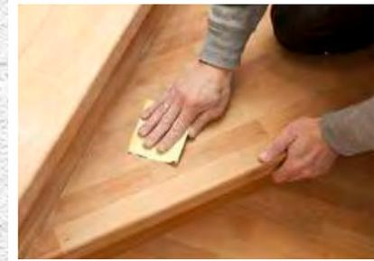
Die Oberflächen mit 240er-Schleifpapier bearbeiten und den Schleifstaub sorgfältig entfernen.
