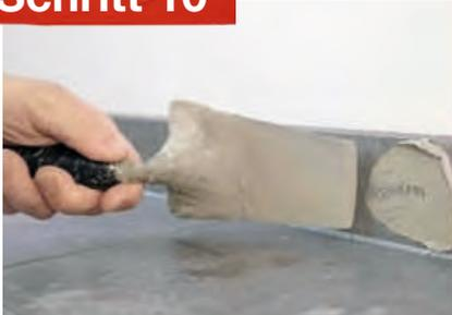
Zum Schluss verfugst du die Sockelfliesen mit einem Spachtel, Fugengummi oder per Hand. Sobald der Kleber getrocknet ist, streichst du die Fugenmasse auf der Oberkante mit dem Finger und dann mit dem Spachtel glatt. Die Dehnungsfuge füllst du mit Silikon auf – aus optischen Gründen sollte das Silikon dieselbe Farbe haben wie der Fugenmörtel.
