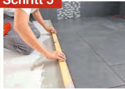
Bei der klassischen Verlegung werden die Fugen per Augenmaß erzeugt. Lege die Fliese an die obere Reihe an, drücke sie leicht ins Kleberbett und ziehe sie mit einer Ruckelbewegung nach unten, bis du die gewünschte Fugenbreite erreicht hast. Falls du einen Höhenunterschied zwischen den Fugen feststellst, gleiche ihn mit sanftem Druck aus. Mit einer Wasserwaage die Flucht der Platten kontrollieren!
