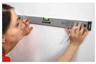
Jetzt hältst du die Wasser-Waage an beide Punkte. Du schaust, ob sie genau auf gleicher Höhe sind. Wenn nicht, korrigierst du es.
