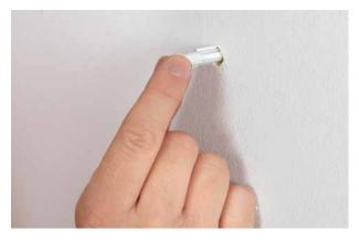
8. Bohrloch prüfen und berichtigen Jetzt nimmst du den Dübel zur Hand. Du willst prüfen, ob er in das Bohrloch passt.
