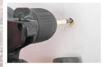
Du bohrst so lange, bis du an der markierten Stelle angekommen bist. Dann machst du die Bohrmaschine aus. Vorsichtig ziehst du den Bohrer aus der Wand zurück. Dabei achtest du darauf, dass du die Bohrmaschine nicht schief hältst. Sonst bricht das Loch jetzt noch aus.
