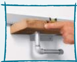
Mit der Wasserwaage das zweite Bohrloch festlegen.
