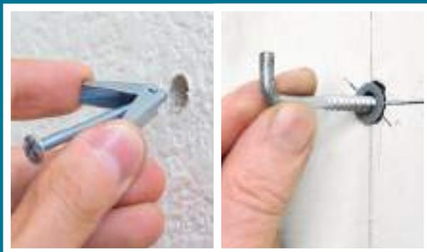
Den Klappdübel in das Bohrloch versenken
