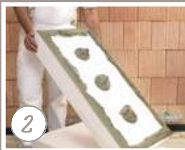
2 Polystyrol-Hartschaumplatte verkleben
