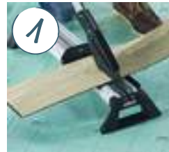
Zuschneiden mit dem Laminatschneider
