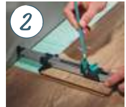
Ausmessen mit dem Laminat-einpasser
