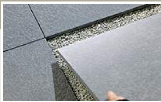
Verlegung im Kiesbett/Splittbett mit Fugenkreuz
