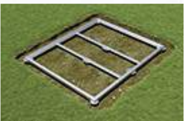
Rahmen und Verbindungsstreben fixieren.
