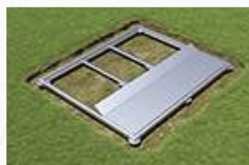
Aludielen einsetzen und befestigen.
