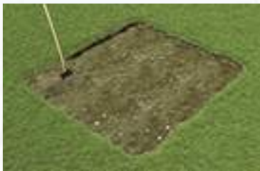
Rasenfläche ca. 10 cm ausheben, Bohrlöcher für Erdschrauben markieren.
