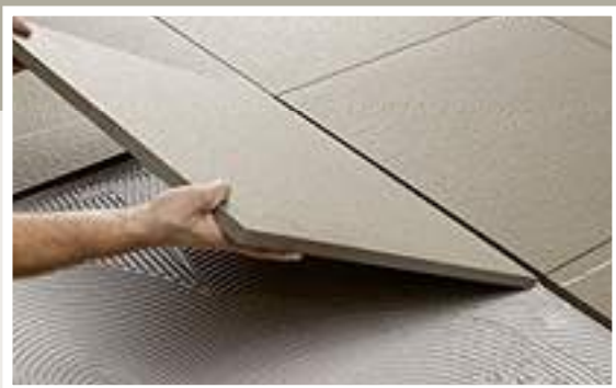
Verlegung auf Kleber/Mörtel
