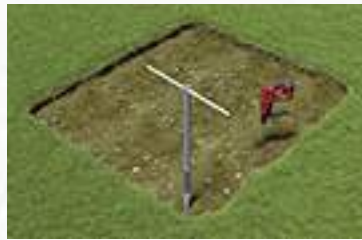
Löcher mit der Schlagbohrmaschine vorbohren, Erdschrauben mithilfe des mitgelieferten Werkzeugs eindrehen.
