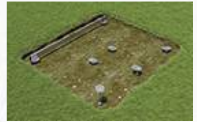
Montageplatten mit Erdschrauben verbinden und mit der Wasserwaage ausrichten.
