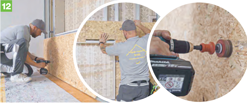
12 OSB-Platten montieren Um deiner Wand mehr Stabilität zu geben, z. B. wenn du später etwas aufhängen willst, kannst du sie zunächst mit OSB-Platten verkleiden. Wenn du eine Steckdose in der Wand eingeplant hast, musst du nun und auch später bei den Gipskartonplatten ans Sägen des benötigten Loches denken.
