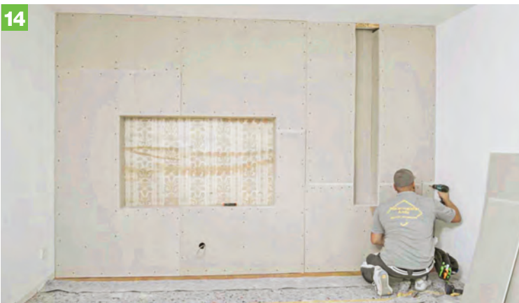
14 Fertig zum Verspachteln Sobald die letzte Gipskartonplatte verschraubt ist, kann es mit dem Verputzen weitergehen. Das zeigen wir dir ab Seite 28.
